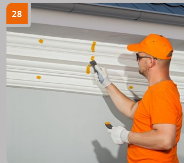
Зашпаклевать обработанные стыки и места заглубления саморезов автомобильной шпаклевкой.
