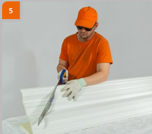
5 С помощью ножовки завершить распил.
