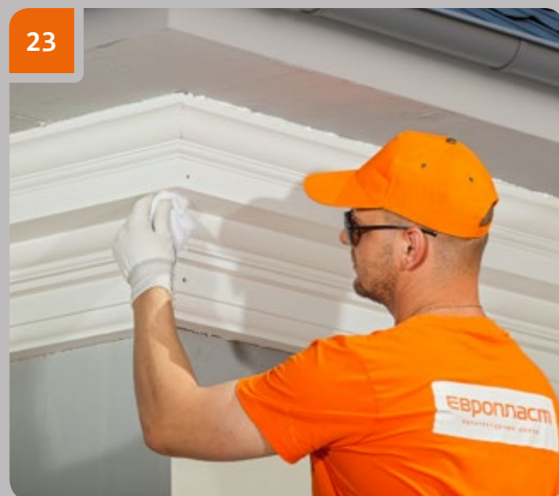
Протереть стык тканью, смоченной ацетоном.
