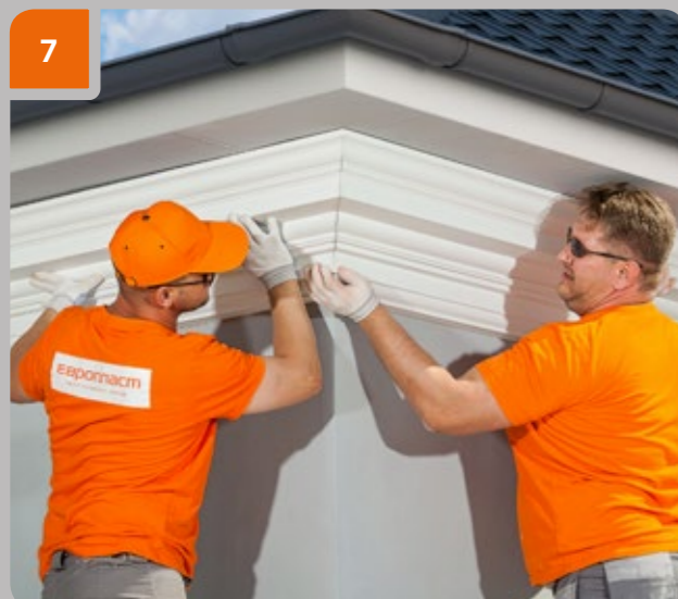
7 Проверить совмещение рисунка и профиля изделий.
