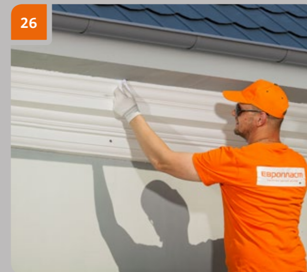
Удалить излишки клея тканью, смоченной ацетоном.
